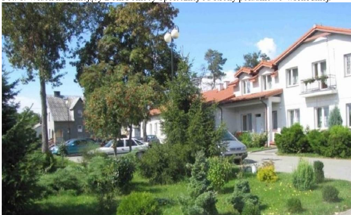
Fot. 1. Widok na istniejący Dom Pomocy Społecznej od strony południowo-wschodniej.
