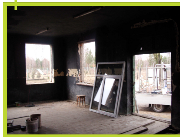
Fotografia 4. Remont budynku byłej szkoły wykonany przez Wspólnotę w celu organizacji świetlicy wiejskiej
